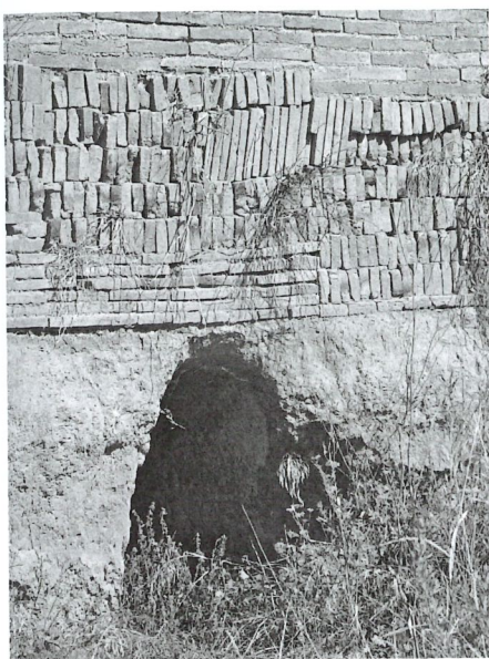
5.1 Bòbila d'en Font: detall d'una obertura a l'exterior
