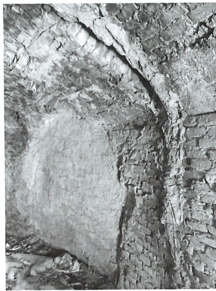
5.2 Bòbila d'en Font: detall de l'interior de l'estructura. (Arxiu fotogràfic: M. Genera).
